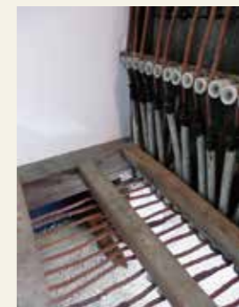
煉瓦独立基礎(配線の奥)
